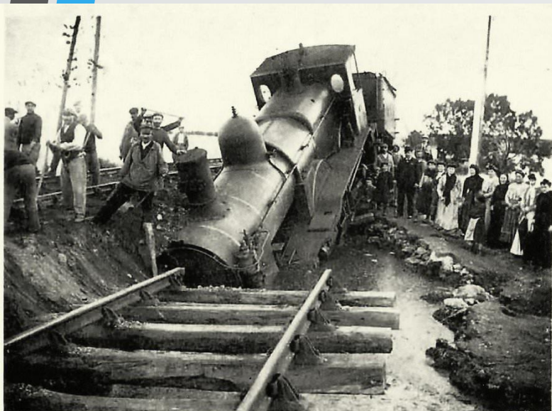
Près FITOU (Pyrénées-Orientales). - Locomotive enlizada par suite des inondations
